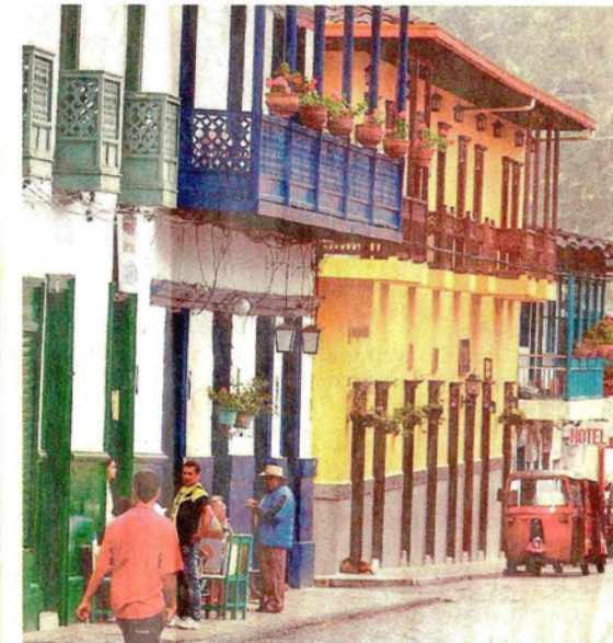
Aspecto del municipio de Jardín, en el que se aprecia la típica arquitectura, al mejor estilo paisa, de muchos pueblos del Suroeste antioqueño.
